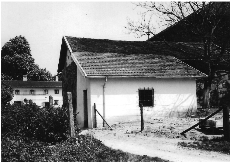
Kühlhaus von aussen
