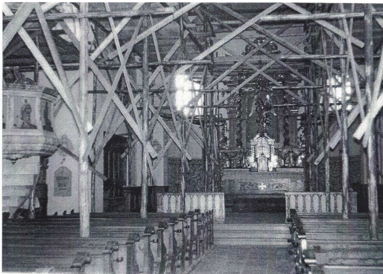
Das eingerüstete Kirchenschiff während der Renovierung 1959.
